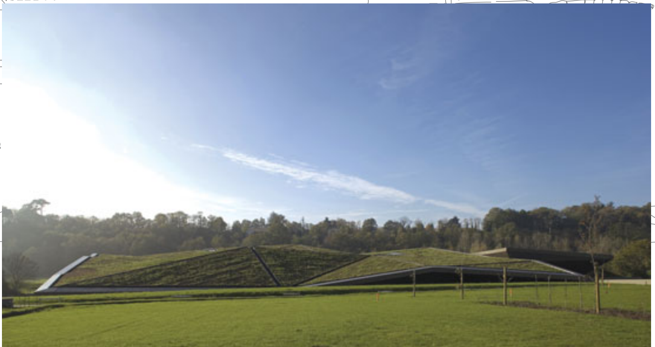
Bâtiment : Historial de Vendée Architecte : Plan 01 - Mr Tan Entreprise : Bergeret et Hervouet Photographe : S. Chalmeau
