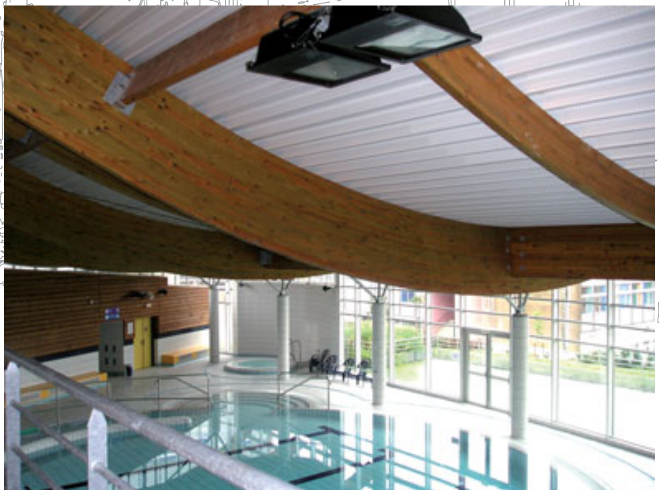
Bâtiment : Piscine de Guingamp Architecte : Grimaud Entreprise : Armor étanchéité
