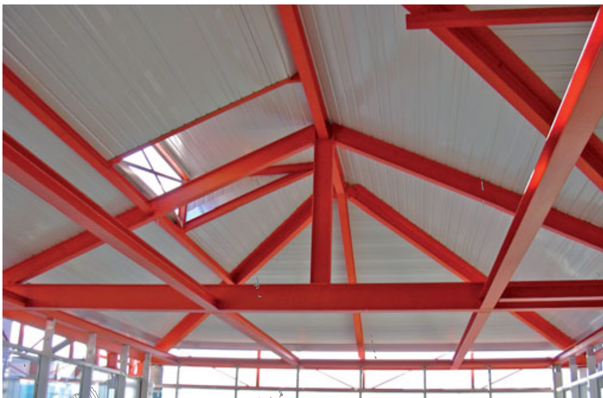
Exemple d'aspect de plateaux HACIERCO en toiture
